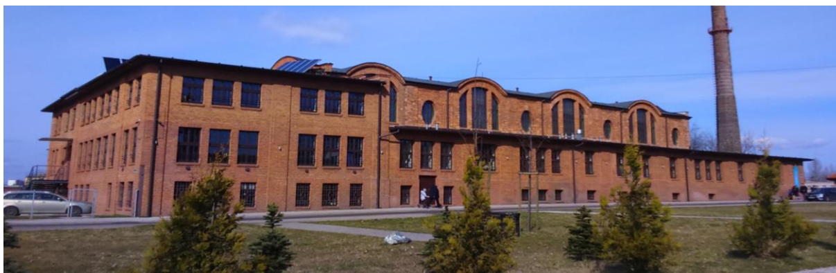
Fot. 1. Adaptacja budynku cechowni dla „Bytomskiego Teatru Tańca i Ruchu Rozbark”
