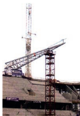
Rys. 25. Montaż dźwigara głównego [1]
