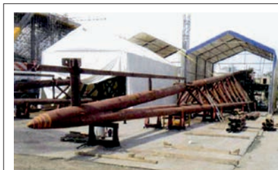
Rys. 24. Element spawany na placu budowy [1]
