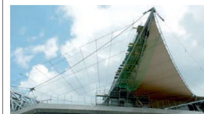
Rys. 26. Montaż membrany [6]
