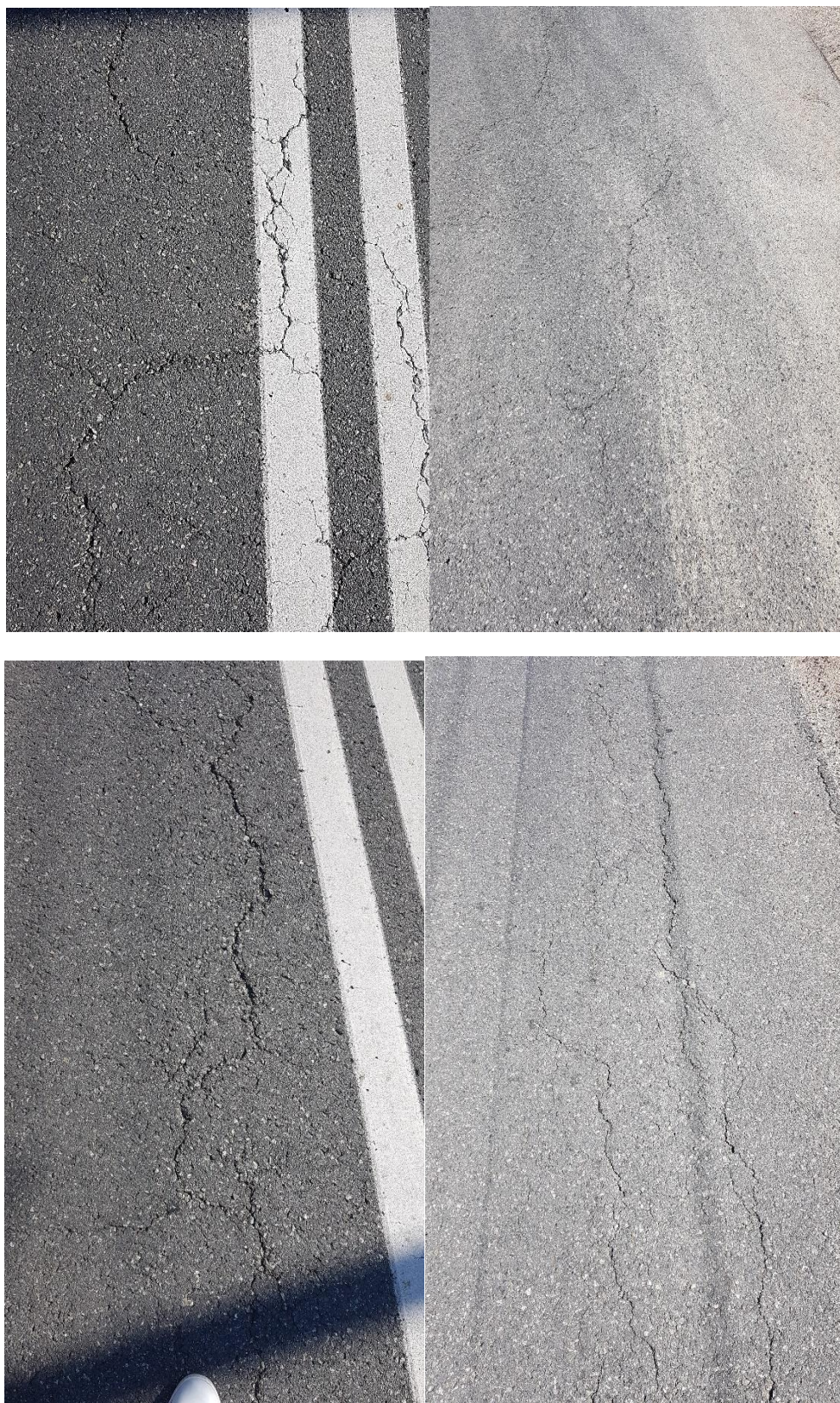
Rysunek 6.20 Przykładowe spękania nawierzchni na poligonie badawczym A – 2019 (zdjęcie własne)
