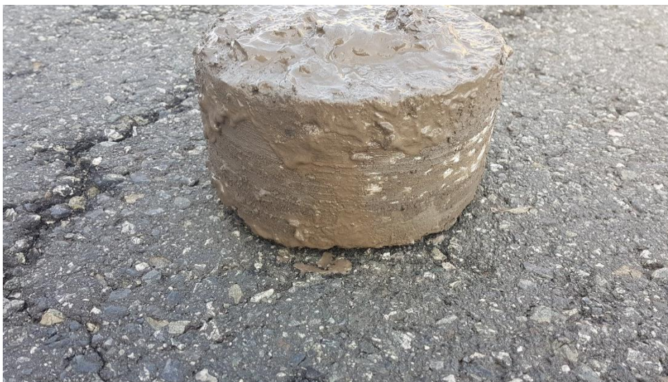
Rysunek 6.12 Odwiert kontrolny w pasie wzmocnionym pomiędzy odwiertem 1 oraz 2 (mat. własny)
