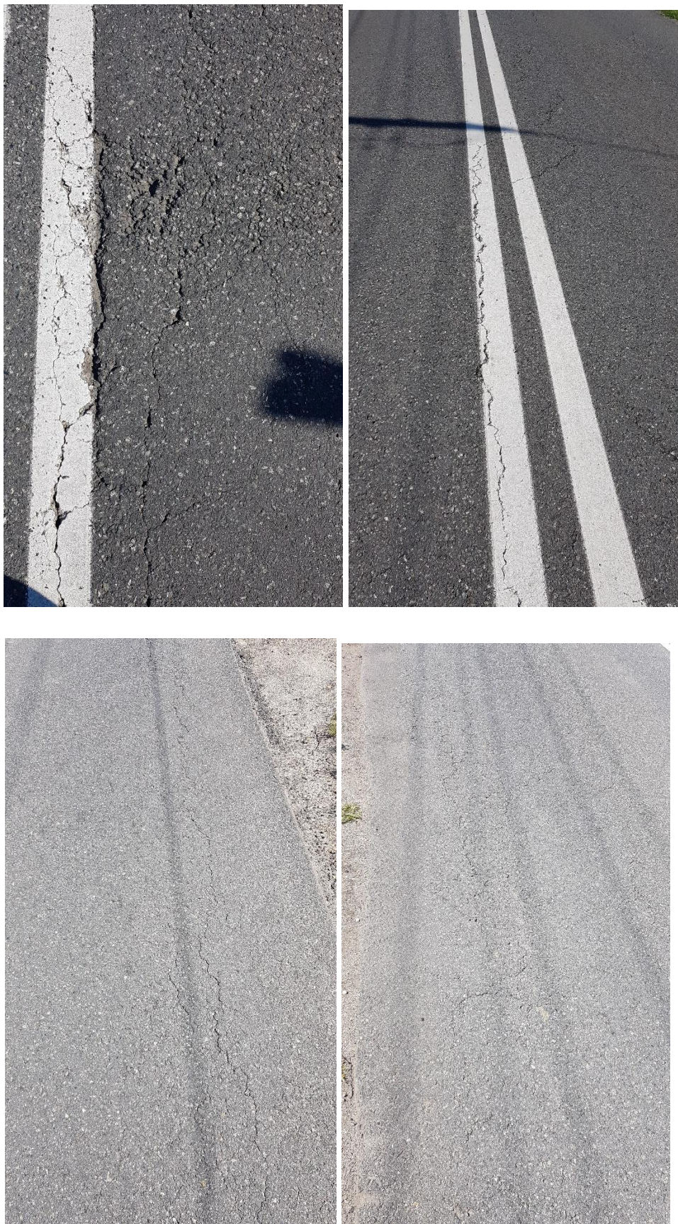
Rysunek 6.22 Przykładowe spękania nawierzchni na poligonie badawczym A na odcinku nr 2 – 2019 (zdjęcie własne)
