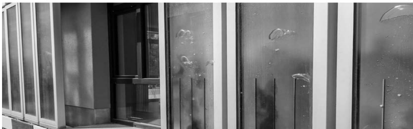
Rys. 2. Panele z algami na fasadzie budynku BIQ w Hamburgu.
