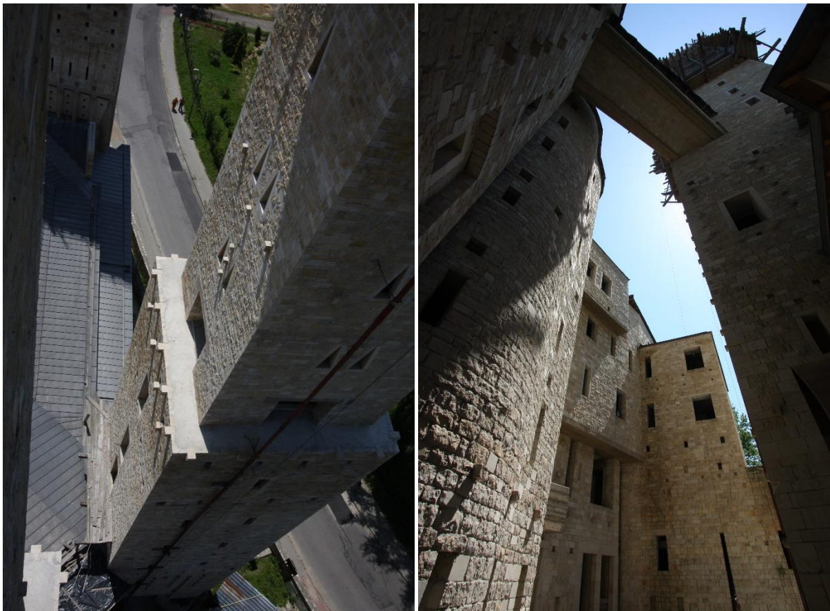
Ryc. 3. Ręcznie wytworzone kamienie ułożone w ścianach i wieżach
