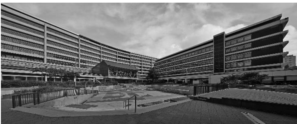
Ryc. 1. Przykłady zrealizowanych przestrzeni hybrydowych (w kolejności opisanej w tekście: 3.1, 3.2, 3.3, 3.4)
