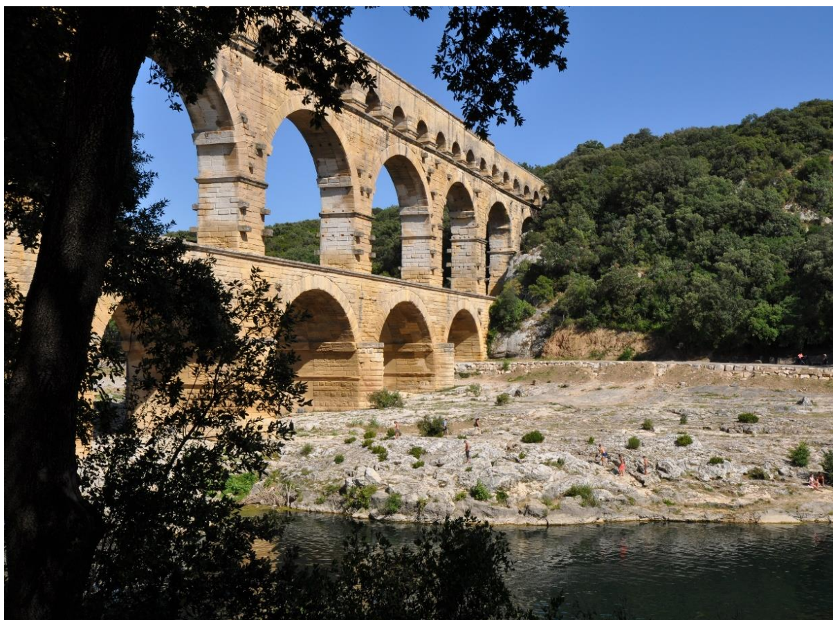
Ryc. 2. Akwedukt Pont-du-Gard w Nimes (I w. p.n.e.) Fig. 2. Aqueduct Pont-du-Gard in Nimes (1 st century AD) Źródło: fotografia autora.
