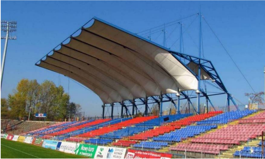
Il. 149. Widok zadaszenia trybuny na stadionie w Bytomiu
