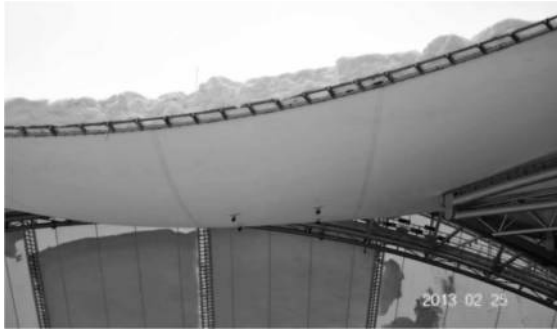
Il. 324. Zadaszenie membranowe obciążone śniegiem 307
