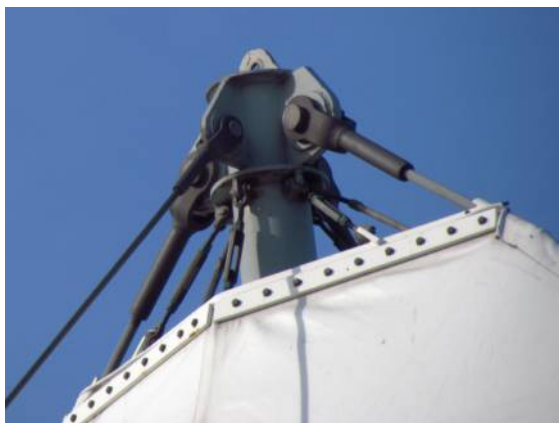
Il. 263. Zamocowanie membrany w Częstochowie
