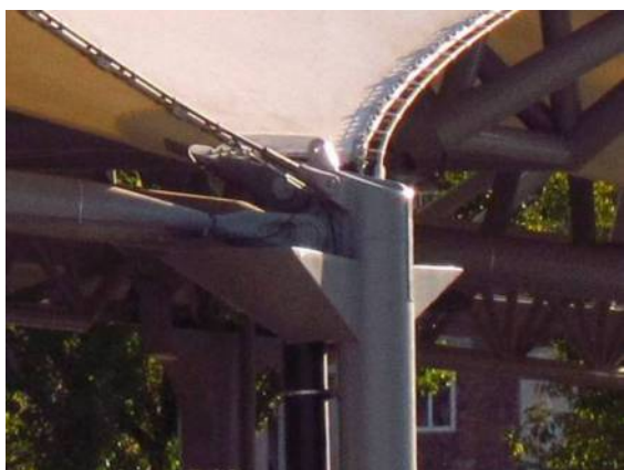
Il. 289. Kielich zadaszenia pętli autobusowej w Warszawie
