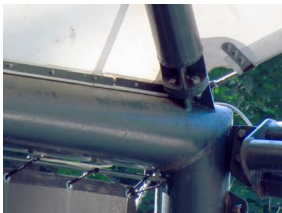
Il. 223. Zamocowanie membrany w zadaszeniu amfiteatru w Łagowie
