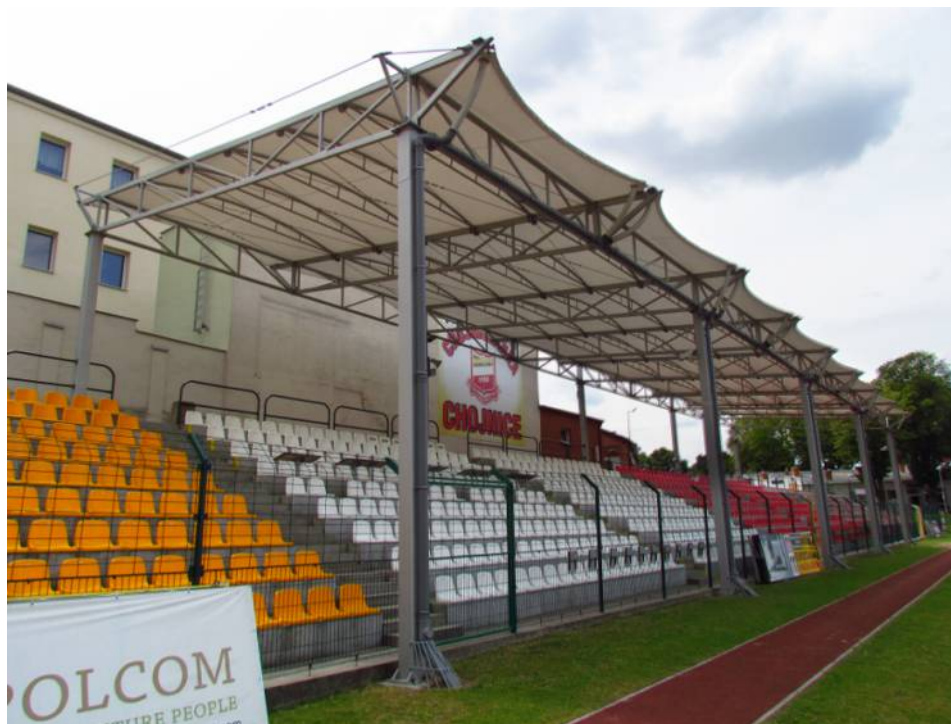
Il. 175. Widok zadaszenia trybuny na stadionie w Chojnicach
