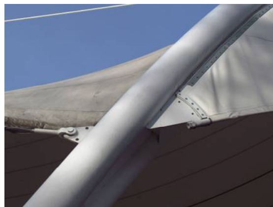
Il. 256. Dwa sposoby zamocowania membrany w zadaszeniu amfiteatru w Ustronie
