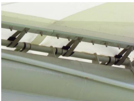
Il. 225. Zamocowanie membrany na stadionie w Gdyni
