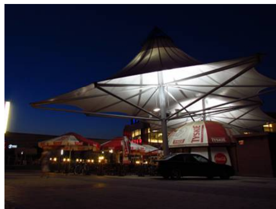
Il. 344. Podświetlenie zadaszenia w Katowicach
