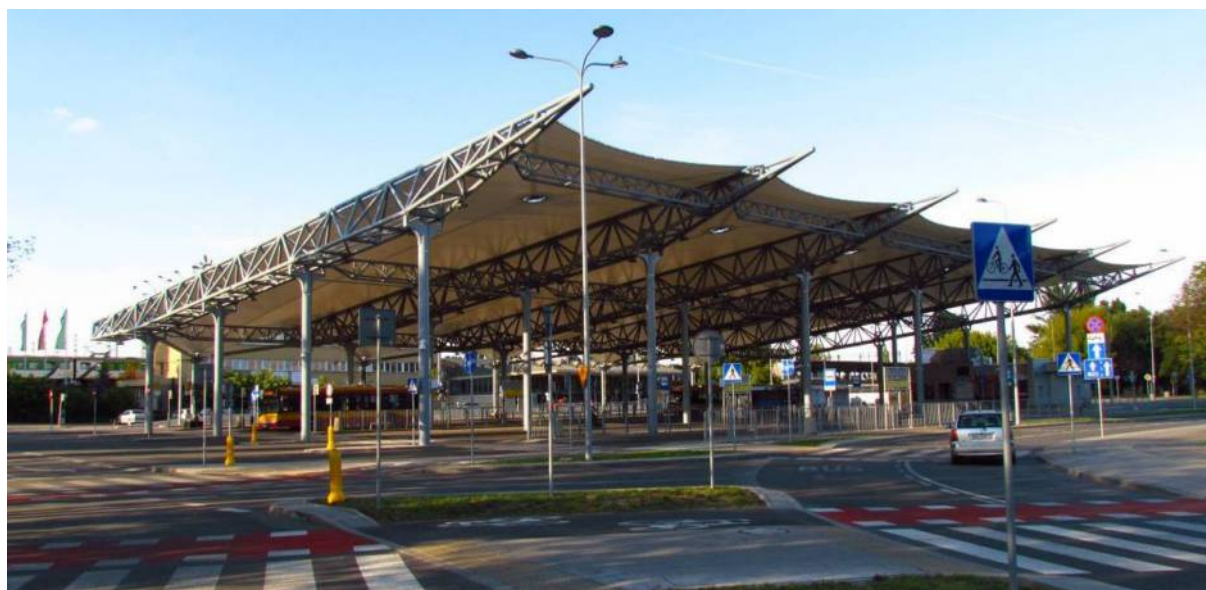
Il. 205. Widok zadaszenia pętli autobusowej w Warszawie
