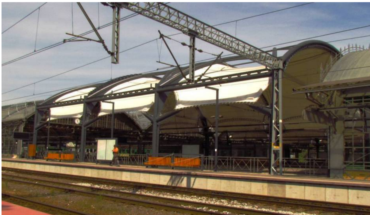
Il. 208. Widok zadaszenia membranowego nad peronami dworca we Wrocławiu
