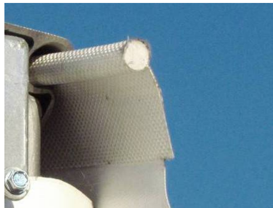
Il. 67. Brzeg membrany wzmocniony taśmą keder
