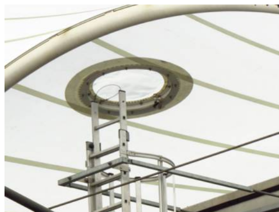
Il. 268. Właz na zadaszenie Stadionu Narodowego w Warszawie
