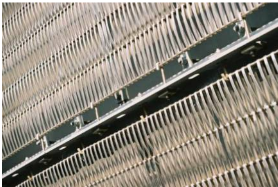
Il. 74. Stalowa siatka elewacyjna Pawilonu M w Hanowerze
