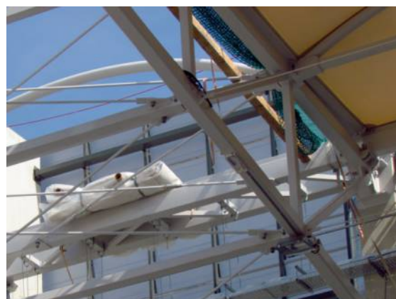
Il. 68. Panel membrany przygotowany do zamocowania na stadionie w Lublinie
