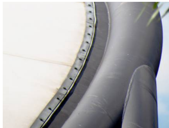
Il. 218. Zamocowanie membrany do łuku w Węgierskiej Górze
