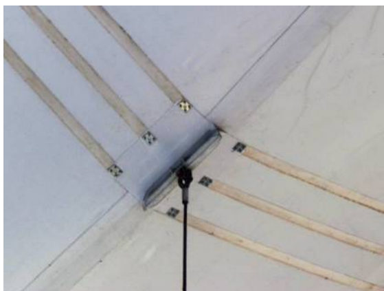
Il. 250. Zamocowanie membrany do cięgna w amfiteatrze w Szczecinie
