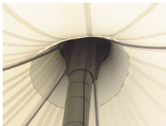
Il. 221. Widok od dołu podparcia pierścienia w Węgierskiej Górze
