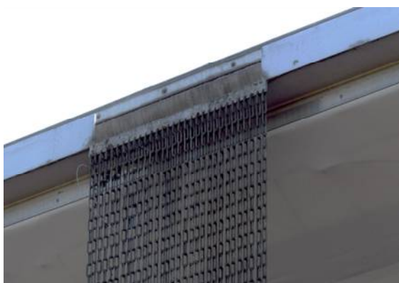
Il. 304. Wiązka łańcuchów do odprowadzania wody
