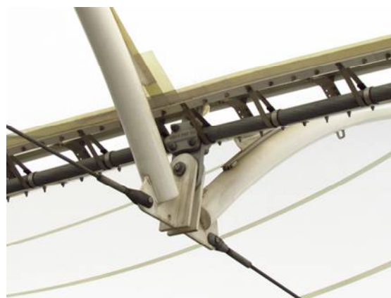
Il. 246. Zamocowanie łuków podtrzymujących membranę na Stadionie Narodowym w Warszawie
