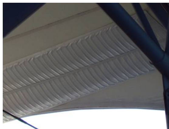
Il. 317. Kable grzejne zamocowane pod membraną
