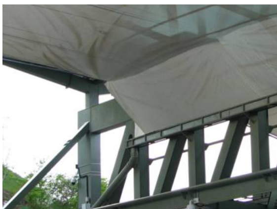
Il. 286. Fartuch łączący membranę z rynną w Kielcach
