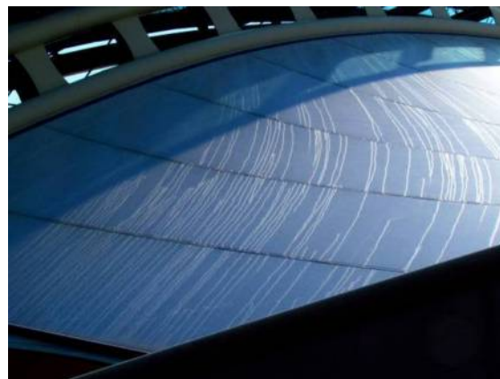
Il. 348. Kierunki spływania wody po zadaszaniu w Wiśle
