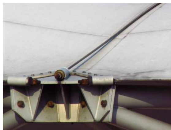
Il. 243. Ciągnio koszowe zadaszenia w centrum handlowym w Katowicach
