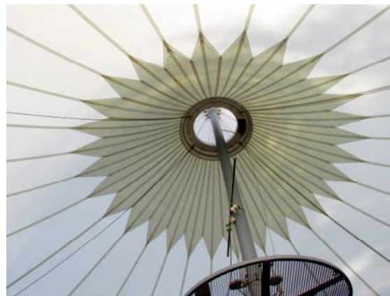
Il. 215. Połączenie brytów w miejscu wzmocnienia powłoki
