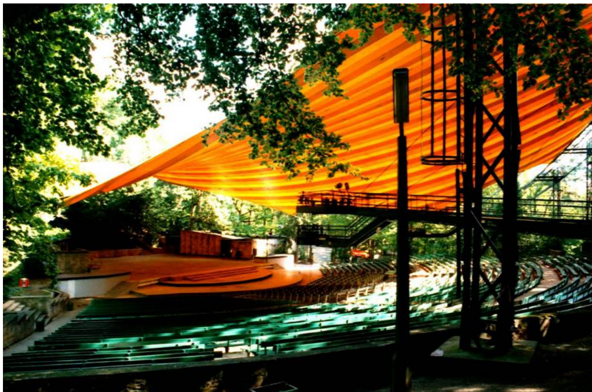
Il. 78. Widok nieistniejącego zadaszania Opery Leśnej w Sopocie
