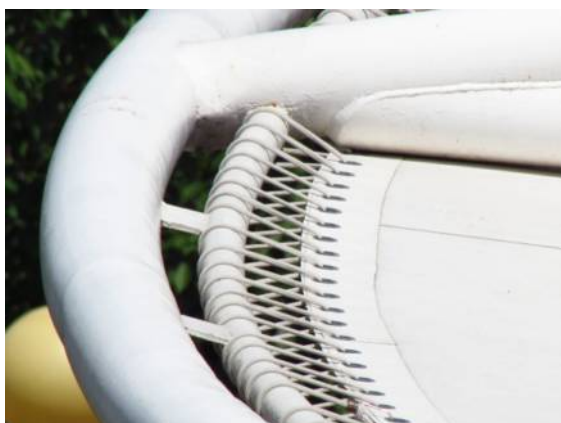
Il. 232. Zamocowanie membrany w zadaszeniu w Poznaniu
