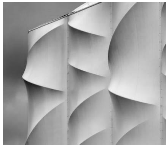
Il. 44. Ściana osłonowa hali do koszykówki w Londynie
