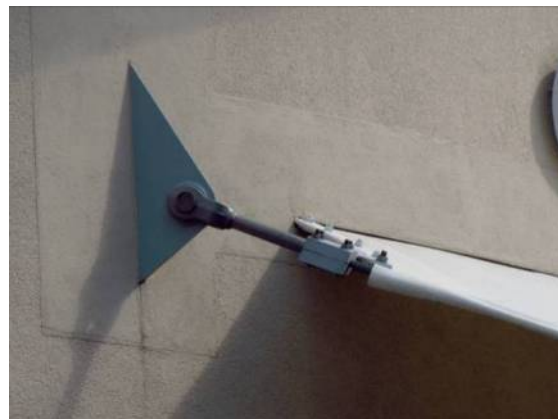
Il. 237. Zamocowanie membrany do ściany w Sopocie
