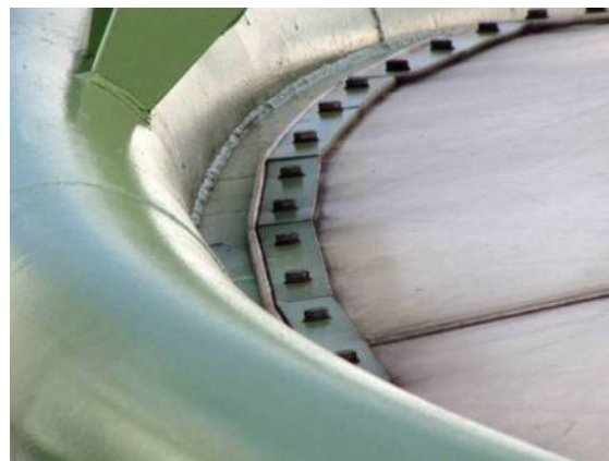
Il. 279. Zamocowanie dolnej krawędzi membrany w zadaszeniu amfiteatru w Brennej
