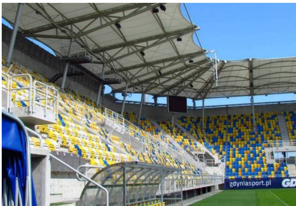
Il. 156. Widok zadaszenia stadionu w Gdyni
