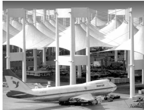
Il. 25. Hajj Terminal w Dżuddzie (Arabia Saudyjska)
