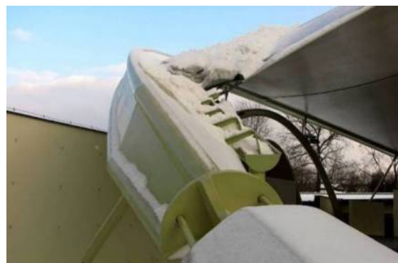
Il. 319. Ochrona rynny przed zsuwającym śniegiem
