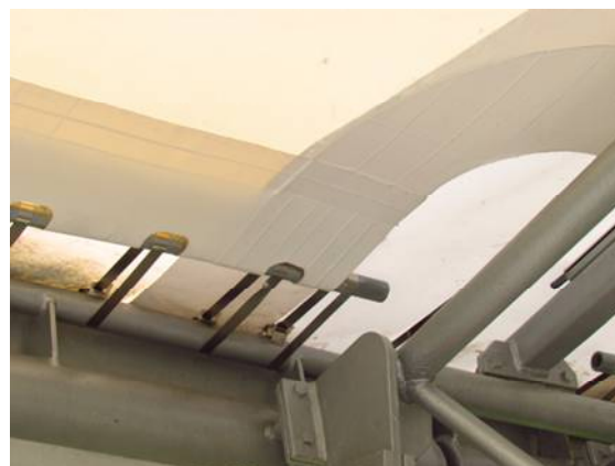
Il. 230. Zamocowanie membrany w amfiteatrze w Sopocie
