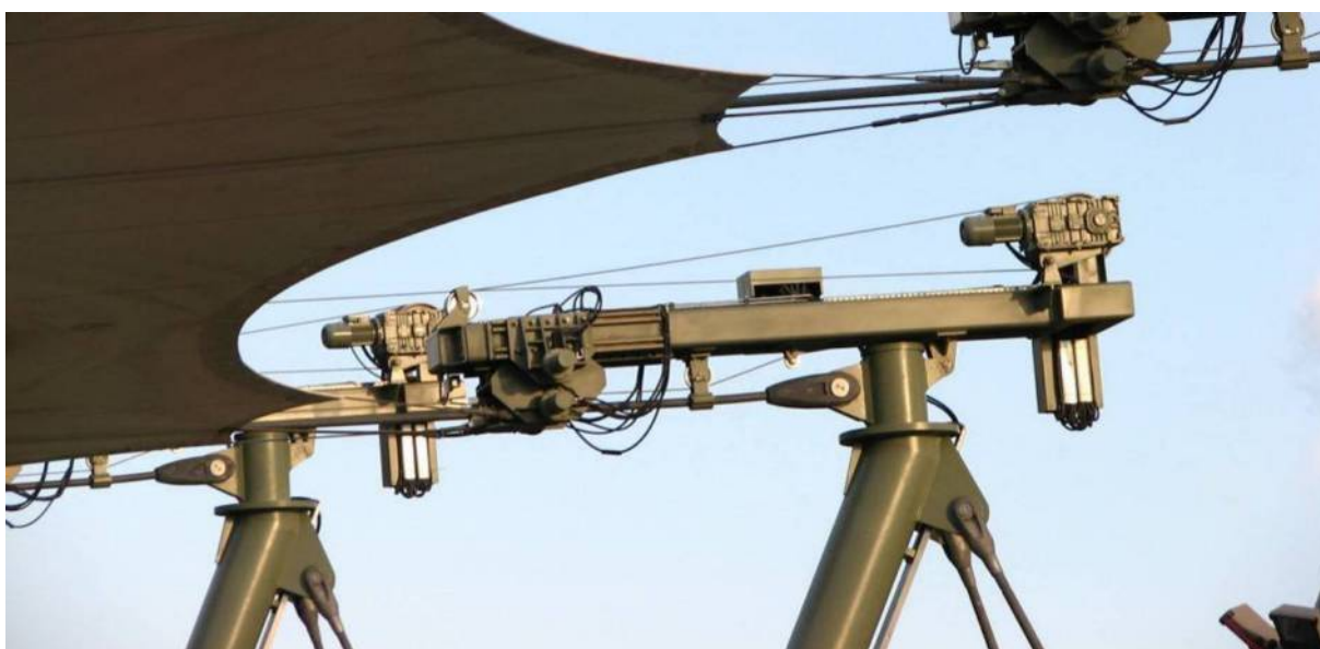
Il. 107. Mechanizmy napędowe ruchomego dachu amfiteatru w Kielcach
