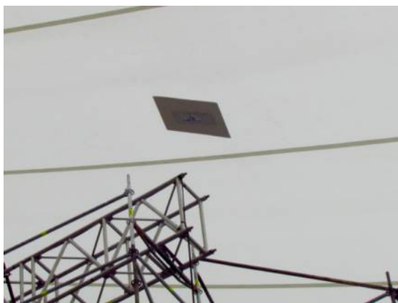
Il. 335. Naprawiony fragment membrany
