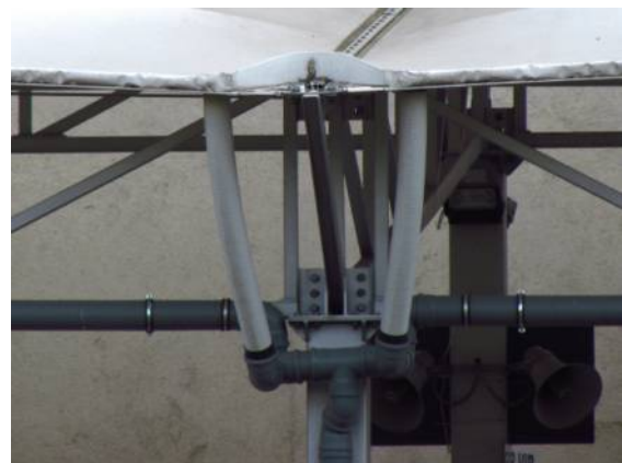
Il. 295. Elastyczne rury spustowe w Chojnicach
