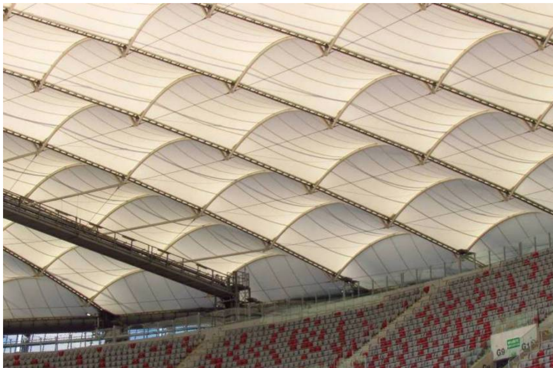
Il. 170. Widok fragmentu dachu stałego na Stadionie Narodowym w Warszawie
