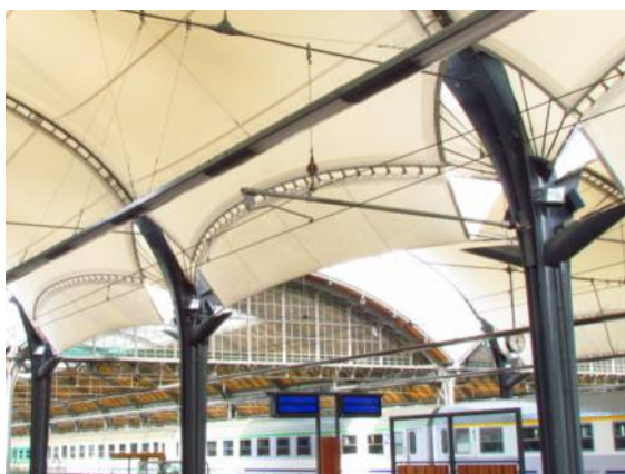
Il. 313. Dodatkowy pas membrany w krawędzi koszowej we Wrocławiu
