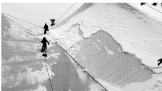
Il. 329. Odśnieżanie zadaszenia membranowego
