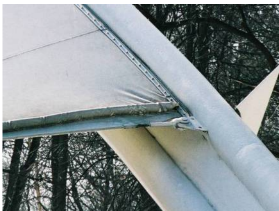
Il. 217. Zamocowanie membrany do łuku w Ustroniu
