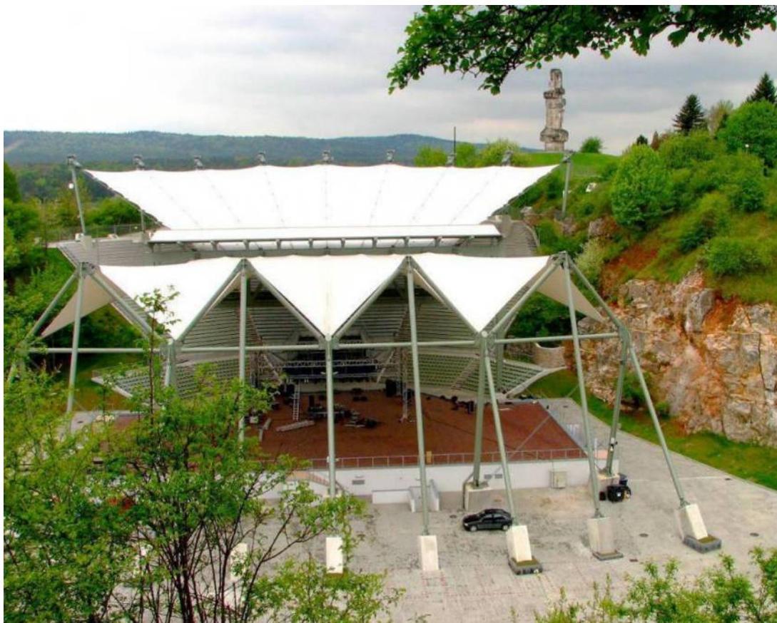
Il. 104. Widok zadaszenia amfiteatru na Kadzielni w Kielcach
