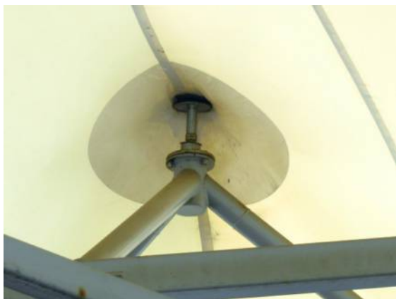
Il. 247. Podpora na stacji paliw w Gdyni – widok od dołu
