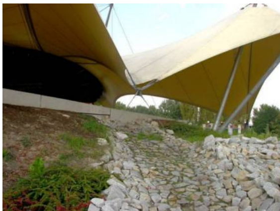
Il. 307. Utwardzony grunt w rejonie splywu wody przy amfiteatrze w Warszawie
