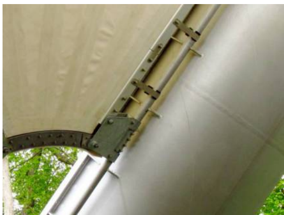
Il. 229. Zamocowanie membrany do łuku w Sopocie, widok od dołu
