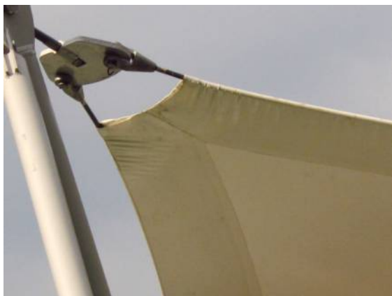
Il. 266. Przykład uproszczonego zamocowania membrany
