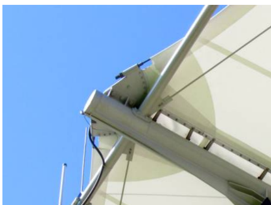
Il. 255. Zamocowanie membrany w zadaszeniu stadionu w Gdyni
