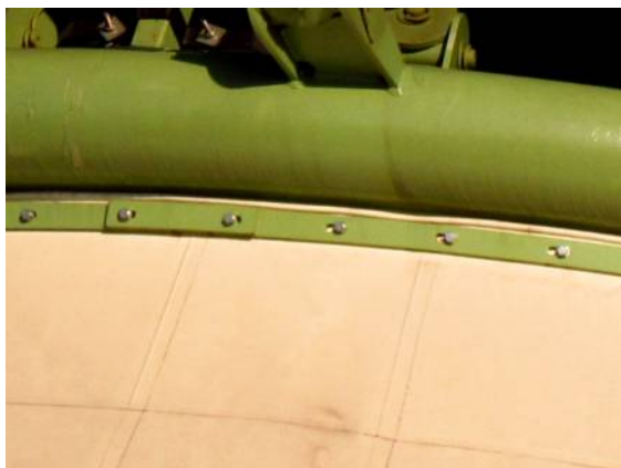
Il. 219. Zamocowanie membrany do górnego pierścienia w Brennej
