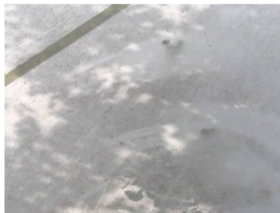
Il. 340. Ślady usuwania brudu na membranie
