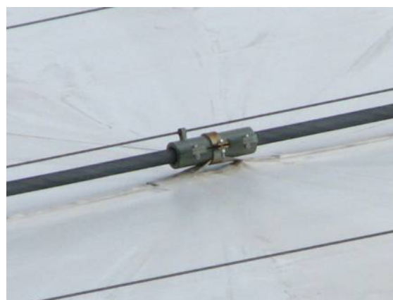
Il. 251. Zamocowanie membrany do ruchomego wózka w amfiteatrze w Kielcach
