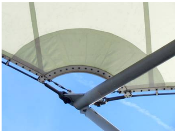
Il. 254. Zamocowanie membrany w Częstochowie
