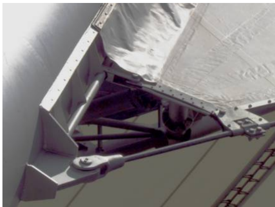
Il. 228. Zamocowanie membrany do łuku w Sopocie
