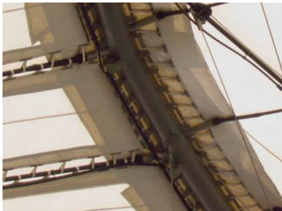
Il. 235. Zamocowanie membrany w zadaszaniu amfiteatru w Płocku
