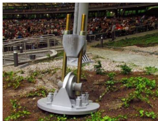
Il. 261. Regulowana długość odciągu w Sopocie
