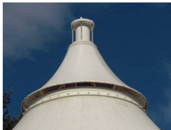
Il. 264. Zamocowanie pierścienia w Sopocie
