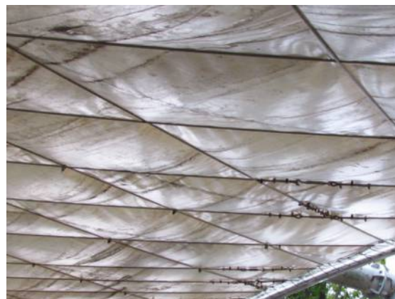
Il. 374. Przykład wzmocnienia membrany za pomocą układu linek
