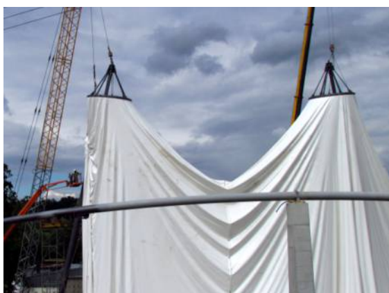
Il. 69. Montaż membrany w amfiteatrze w Żywcu
