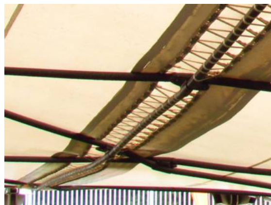
Il. 363. Połączenie kabli pod membraną
