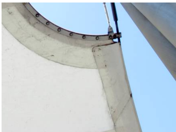
Il. 238. Zamocowanie membrany za pomocą cięgna brzegowego w Katowicach
