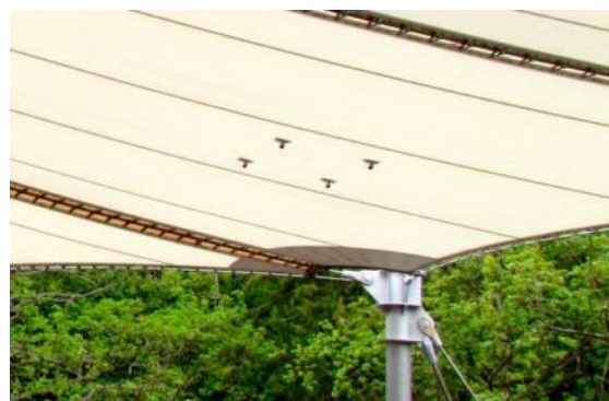
Il. 322. Zamocowanie pryzmatów pomiarowych bezpośrednio do membrany
