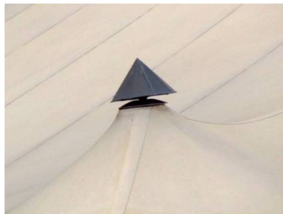
Il. 248. Podpora punktowa na stacji paliw w Gdyni
