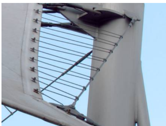
Il. 241. Zamocowanie membrany w zadaszeniu w Kołobrzegu
