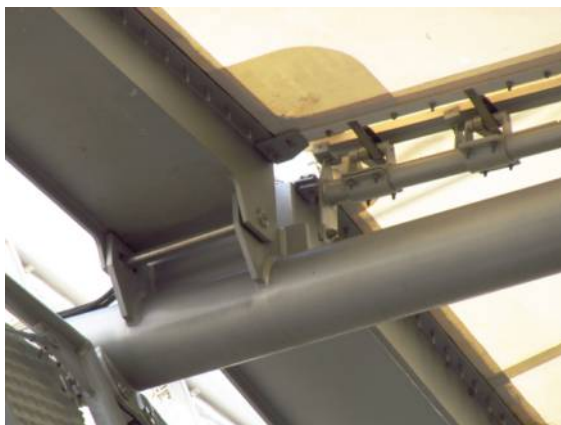
Il. 222. Zamocowanie membrany w zadaszeniu Stadionu Narodowego w Warszawie
