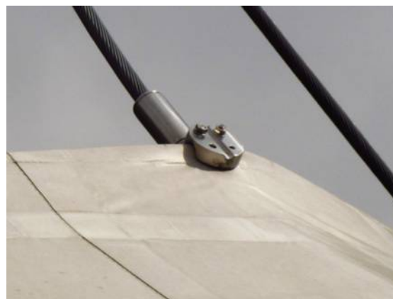
Il. 257. Górne zamocowanie membrany w Łańcut
