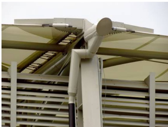
Il. 296. Kielich spustowy leżący na membranie stadionu w Gdyni
