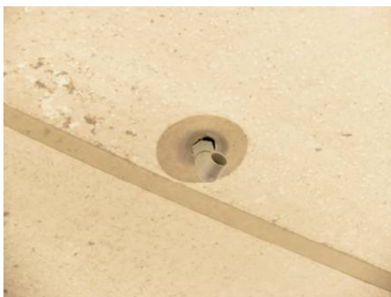
Il. 300. Dodatkowy odpływ w zadaszeniu w Zubrzycy Górnej
