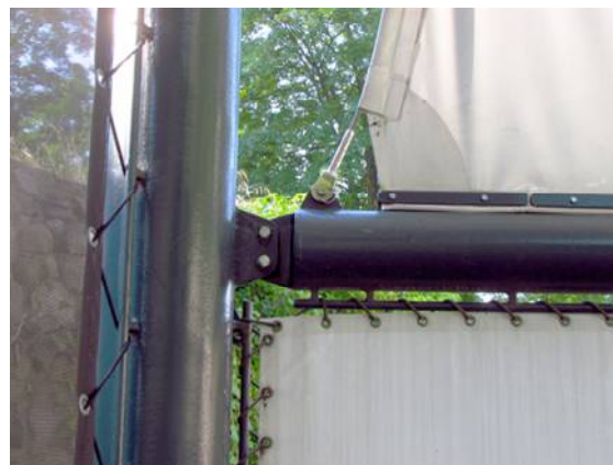
Il. 233. Zamocowanie membrany amfiteatru w Łagowie
