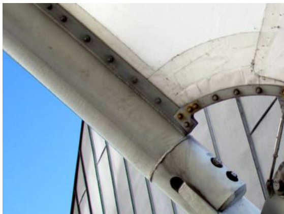
Il. 216. Zamocowanie membrany do łuku w Katowicach
