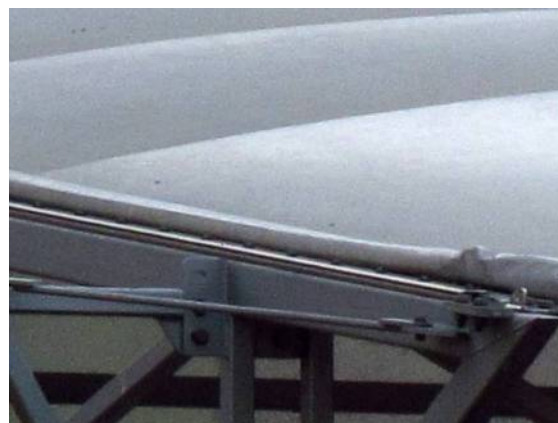
Il. 224. Zamocowanie membrany w Chojnicach
