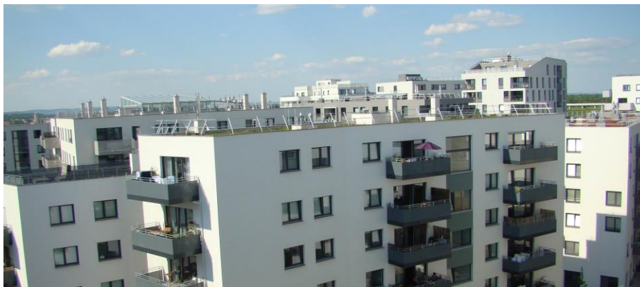
Rys. 1. Widok dachów budynków przygotowanych do instalacji PV
