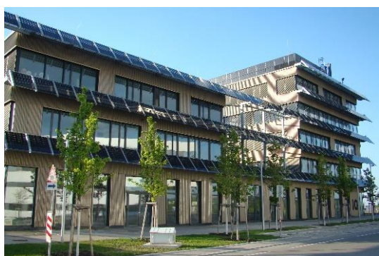
Rys. 2.,3. Budynek IQ Centre z instalacją PV na elewacji
