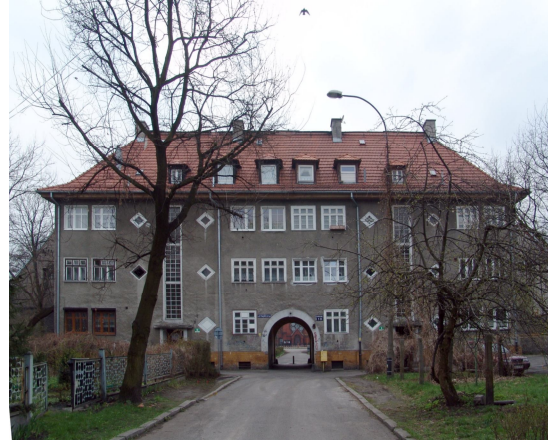
Ryc.10 Budynek z bramą przejazdową przy ul. Kaplicznej – fot. Ewa Pokorska
