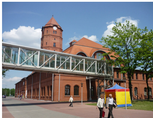
Ryc.2 Nowe Gliwice, dawna cechownia po rewitalizacji. Fotografia wykonana w trakcie Dni Europy, maj 2009.
