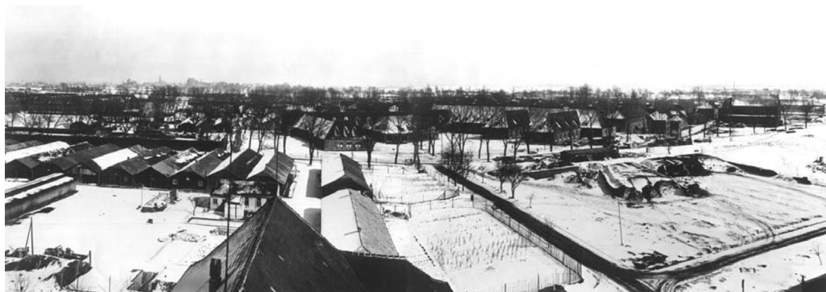
Ryc.7. Oświęcim, luty 1945. Zdjęcie wykonane z budynku Monopolu Tytoniowego w kierunku południowo-wschodnim. Na pierwszym planie widoczne tereny „Bauhof” - składu budowlanego KL Auschwitz. W głębi od lewej: „Schutzhaftlagererweiterung”, historyczne śródmieście Oświęcimia, zabudowa obozu macierzystego, w tym budynek tzw. „Teatru”. Fot.: St.Mucha [Archiwum PMO nr neg. 796 i 797]
