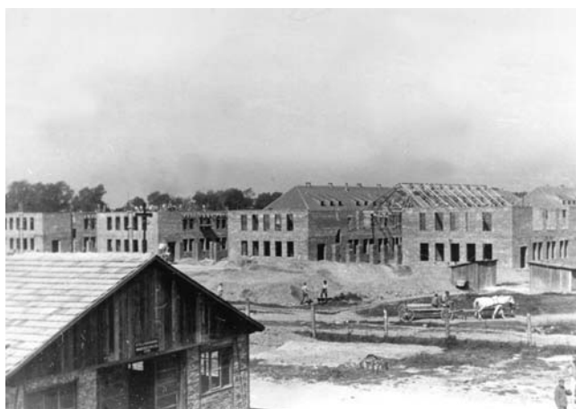
Ryc.6. Jedno ze zdjęć rozbudowy KL Auschwitz I wykonywanych przez SS jako załączniki do sprawozdań budowlanych. W głębi widoczny zespół nowo wznoszonych bloków więźniarskich „Schutzhaftlagererweiterung” [Archiwum PMO nr neg. 20995/56]
