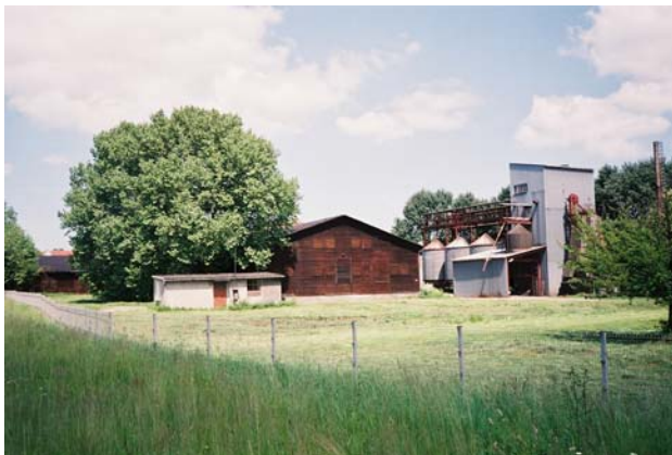
Fot.23. Oświęcim, ulica Kolbego. Drewniany barak „SS-Küche” - była kuchnia i jadalnia esesmańska. Ujęcie w kierunku północnym
