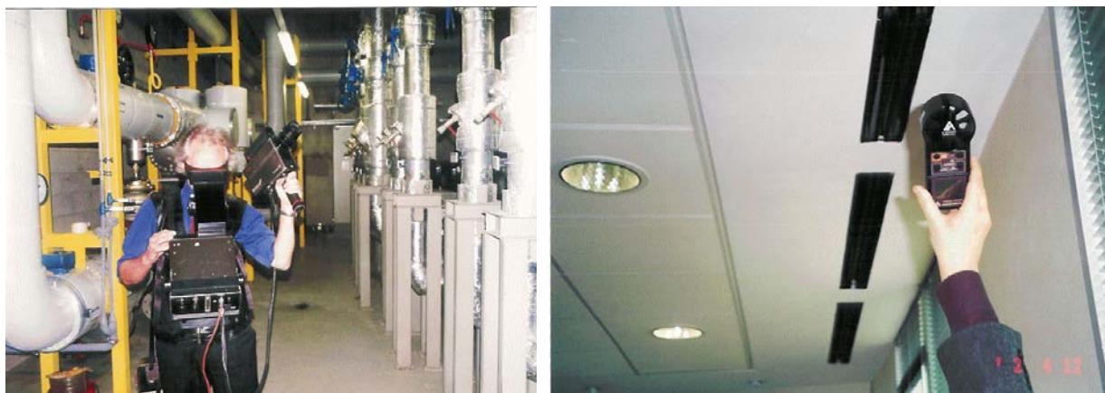
Rys. 43. Fotografowanie: a) przecieków ciepła w instalacjach budynku inteligentnego przy użyciu techniki pomiaru fotograficznego termowizyjnego, b) pomiar natężenia oświetlenia przy użyciu luksomierza (fot. K. Fross w 2000 r.)
